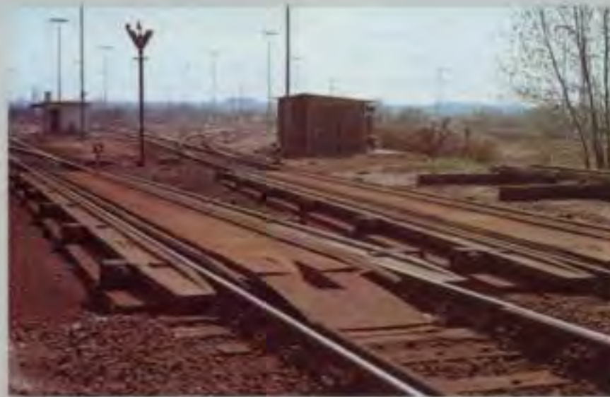
Abb. links: Fernbediente Gleisbremsen in der Richtgleisgruppe - Rangierbahnhof Mannheim.
